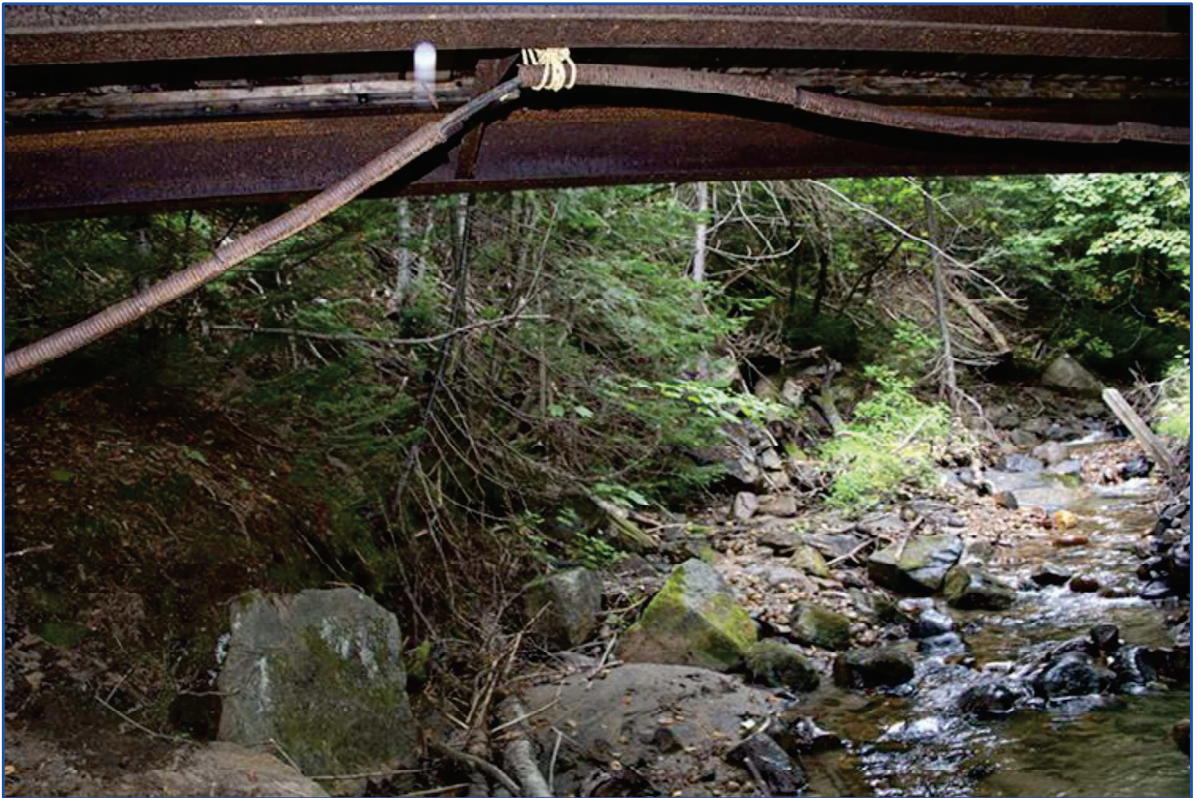
Photo 5 Vue sous le pont, rive sud-ouest.
