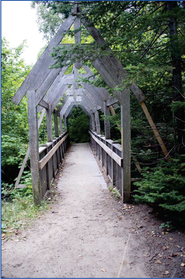
Photo 1 Approche, vue de la rive nord-est.
