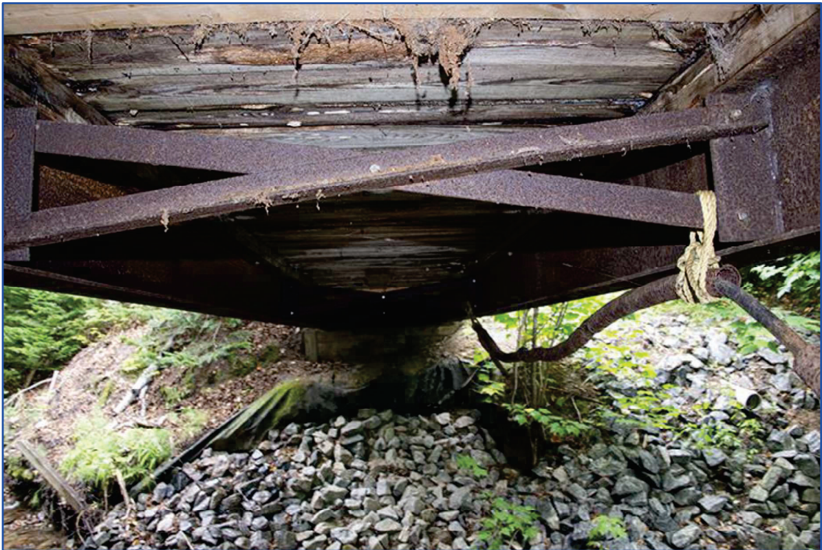
Photo 5 Vue sous le pont, rive nord-est.
