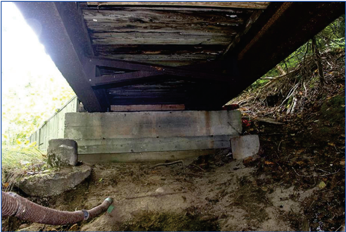
Photo 5 Vue sous le pont, rive sud-ouest
